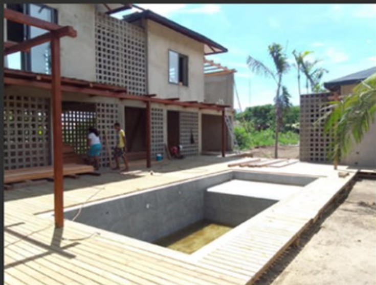
MISE EN PLACE DU DECK
