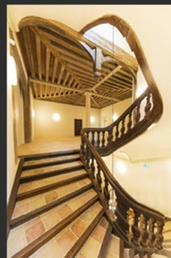
Restauration d'un escalier classé
