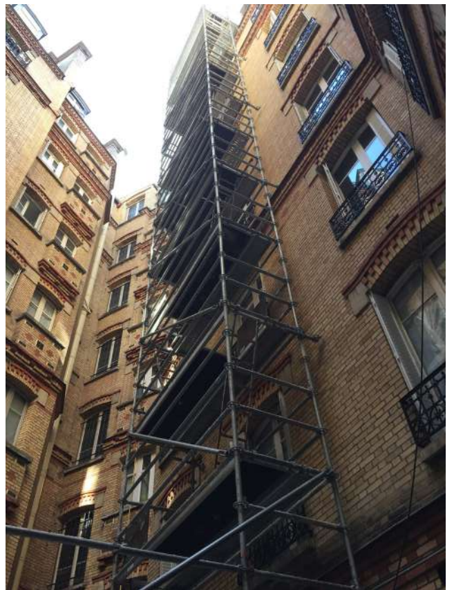
Façade rue du Rocher / Plan de RDC contextualisé / Photos de chantier
