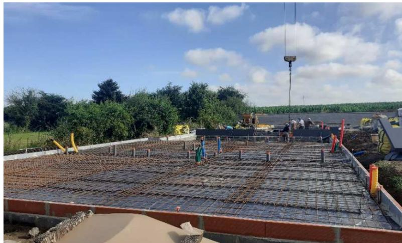
Pose du biocofra et réalisation du ferrailage
