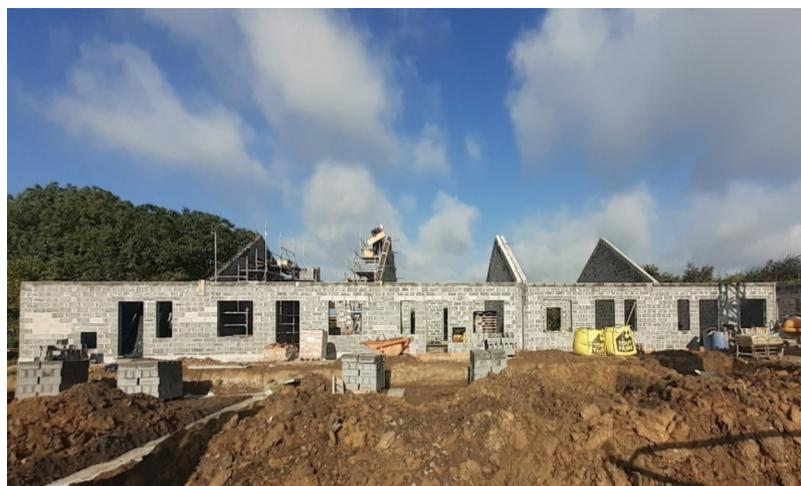
Coulage de la dalle effectué, réalisation des élévations et des murs de refend
